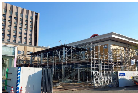
建設工事の様子
